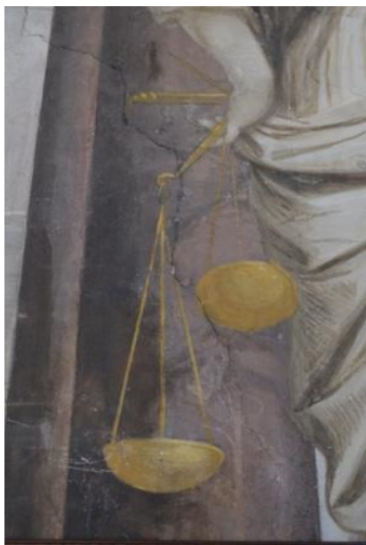
Fratture e fessurazioni
